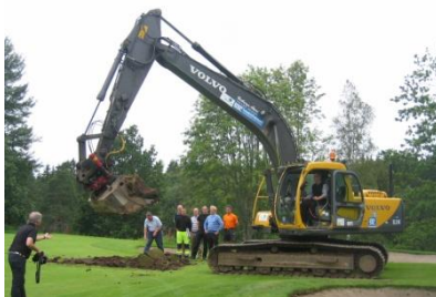
STARTEN AV RENOVERINGEN
